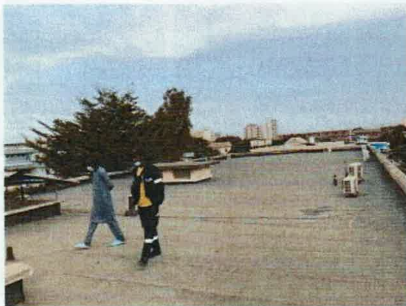
Figure 1 : toit du bâtiment de neurochirurgie
